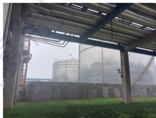
北侧苯乙烯储罐
