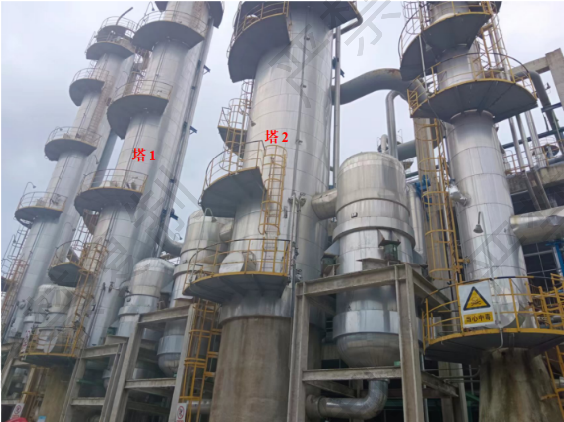
本项目装置（塔 1、塔 2 为需要更换的塔）
