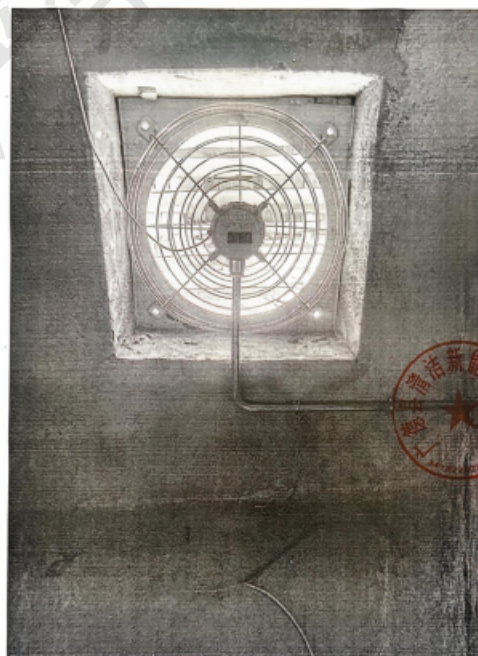
整改照片 4: 成品仓库电源风机已接线投用
