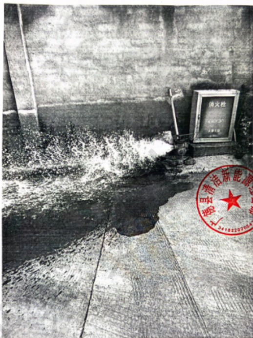
整改照片 3: 消防灭火系统已正常投用
